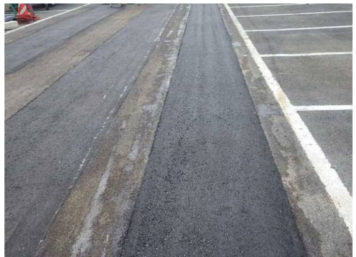
⑤ 作業完了
